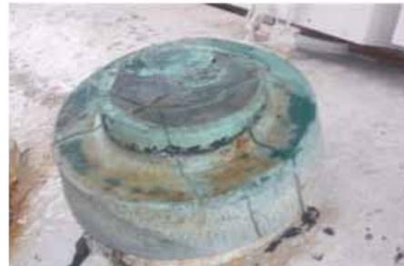
Válvula encofrada con cemento.
