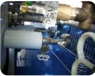
VÁLVULAS DE VACIADO DE EMERGENCIA
